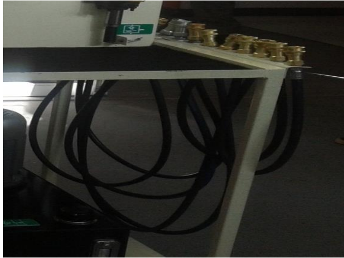
Figura 19.5 Instalación de almacén de mangueras
